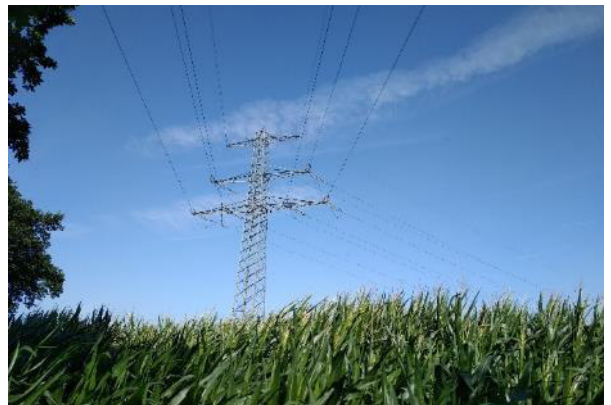
Abb. 19g: Blick auf den Mast Nr. 126 mit 110-kV-Überlandleitung im Plangebiet
