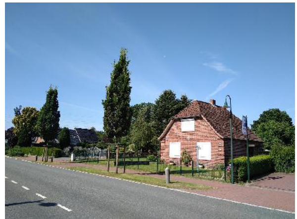
Abb. 10b Blick von Nordosten auf das Grundstück Dorfstraße Nr. 87, welches für die Erschließung des geplanten Wohngebiets als Zufahrt genutzt werden soll
