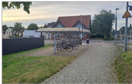
Abbildung 42: Bike+Ride-Anlage westlich der Bahn
