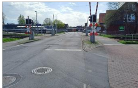
Abbildung 39: Bahnübergang mit Haltelinie vor der Schranke
