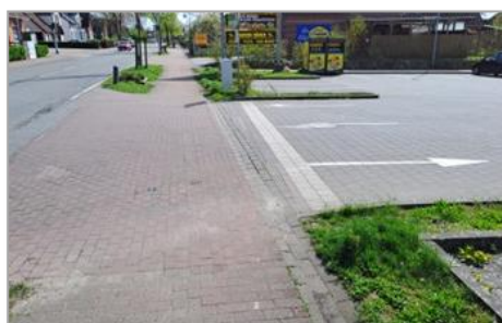
Abbildung 26: Gehwegüberfahrt am Parkplatz Einkaufszentrum
