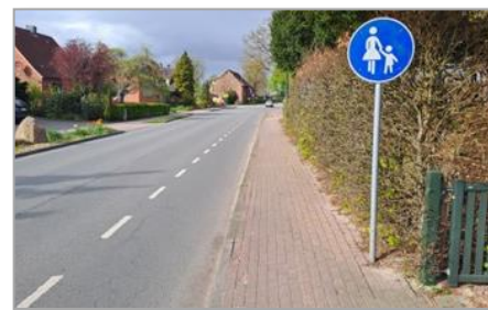
Abbildung 15: Nördlicher Abschnitt Dorfstraße mit Schutzstreifen und nicht freigegebenen Gehweg
