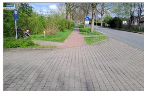
Abbildung 32: Einmündung Ostlandring Süd/Dorfstraße ohne Furtmarkierung
