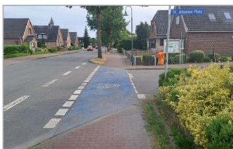
Abbildung 25: Einmündung St. Johannes-Platz: fehlendes Schild, abgängige Markierung
