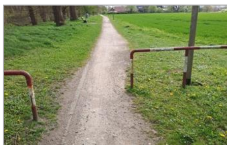
Abbildung 23: Durchfahrtsbegrenzung am Waldrand
