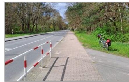
Abbildung 17: Fehlende Querungshilfe an der K55 Neue Reihe
