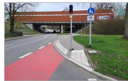
Abbildung 13: Rotmarkierung einer Fahrradfurt am Kamper Weg in Itzehoe
