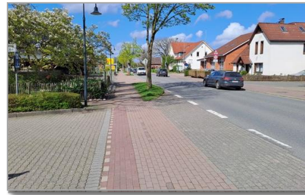
Abbildung 14: Als Gehwegüberfahrt mit Pflasterung gestaltete Einmündung in Kremperheide
