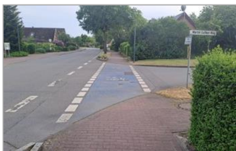
Abbildung 27: Einmündung Martin-Luther-Weg: fehlendes Schild, mangelhafte Markierung
