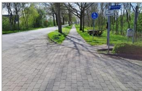
Abbildung 31: Einmündung Ostlandring Süd/Dorfstraße ohne Furtmarkierung
