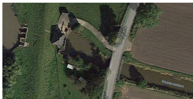
Das Pumpenhaus in Hodorf Quelle: google maps
